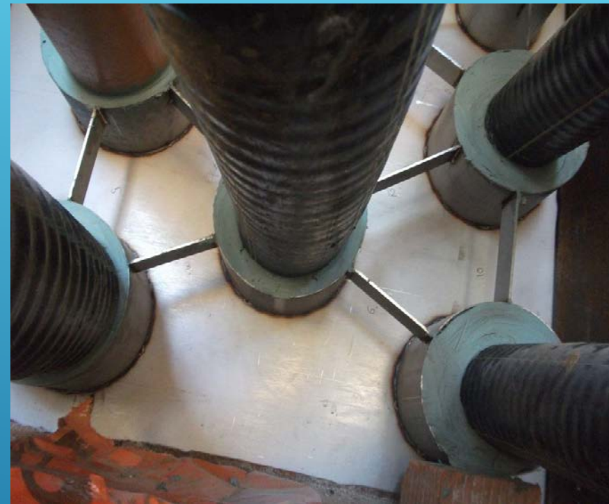
Со стороны грунта
